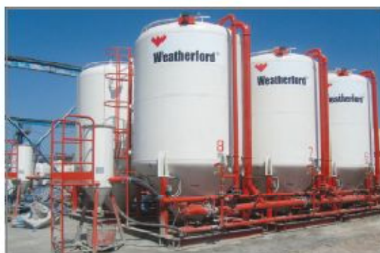
Стационарный склад ЗЦС-40
